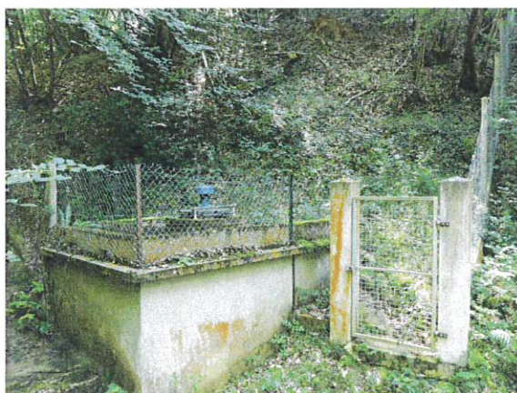
Vue d'ensemble de l'extérieur du captage
