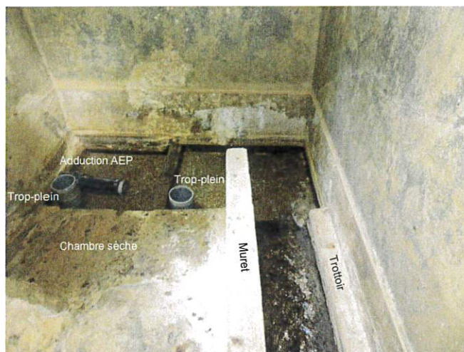
Vue d'ensemble de l'intérieur du captage
