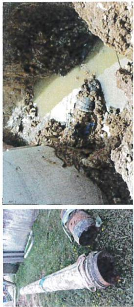
Après la mise en place du pompage provisoire de déviation de l'alimentation en eau du bassin d'aération existant, SUEZ Eau France a fait réaliser un curage de la zone de contact et du tronçon de canalisation sous radier afin de pouvoir réaliser le passage caméra.
