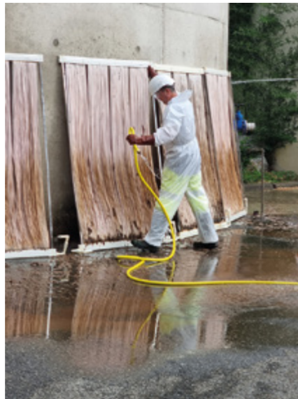
Extraction et nettoyage des membranes de la station d'épuration de Nailloux
