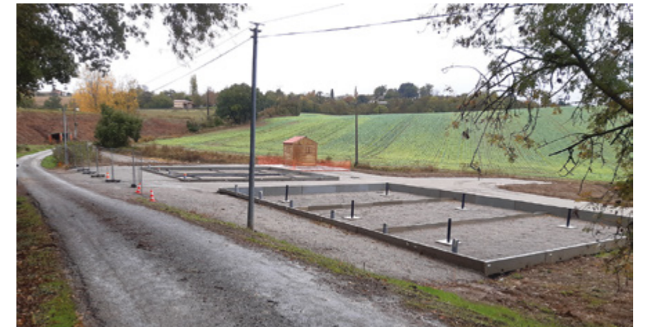
Construction de la station d'épuration de Sainte-Livrade
