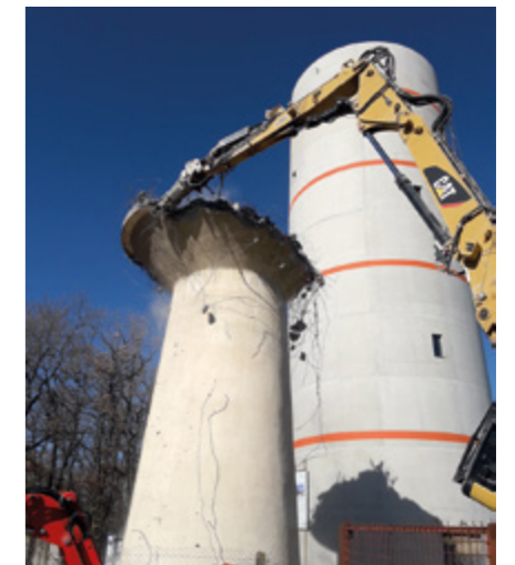
Construction du nouveau réservoir de Préserville
