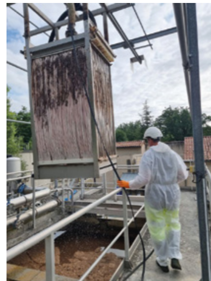
Extraction et nettoyage des membranes de la station d'épuration de Nailloux
