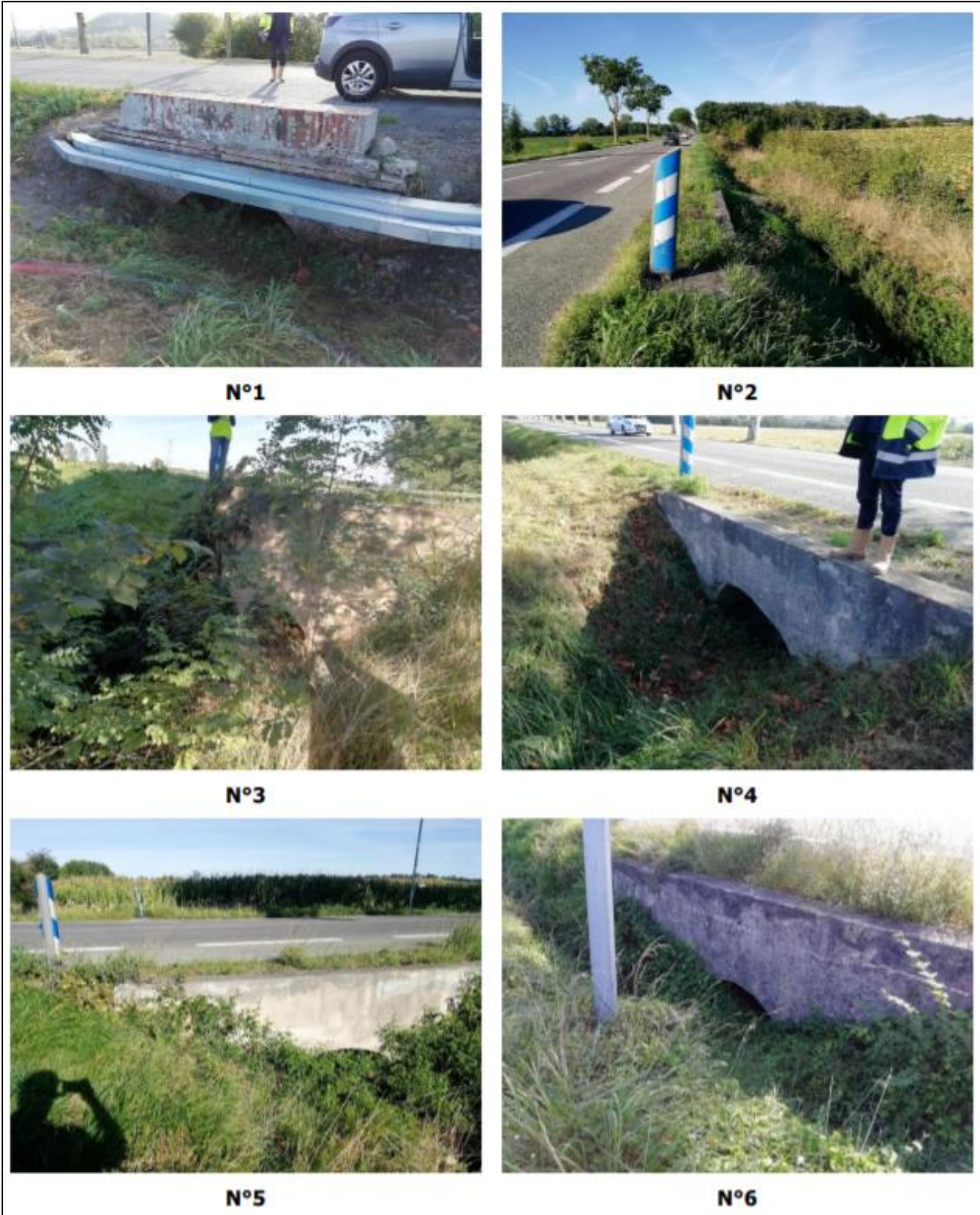
Figure 8 : Ouvrages hydrauliques recensées sur le tracé du tronçon n°1
