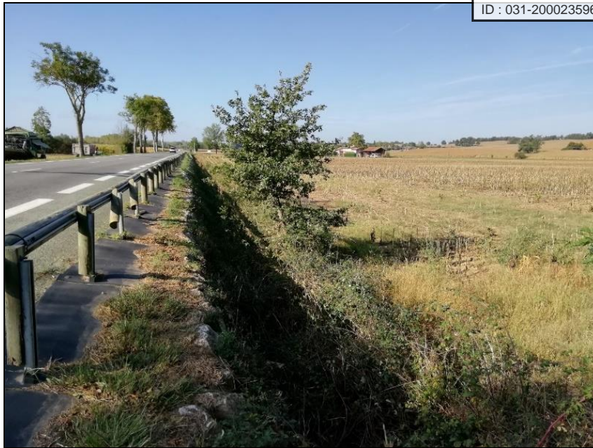
Figure 11 : Zone complexe vues amont ouvrage / Droit ouvrage / Aval ouvrage)
