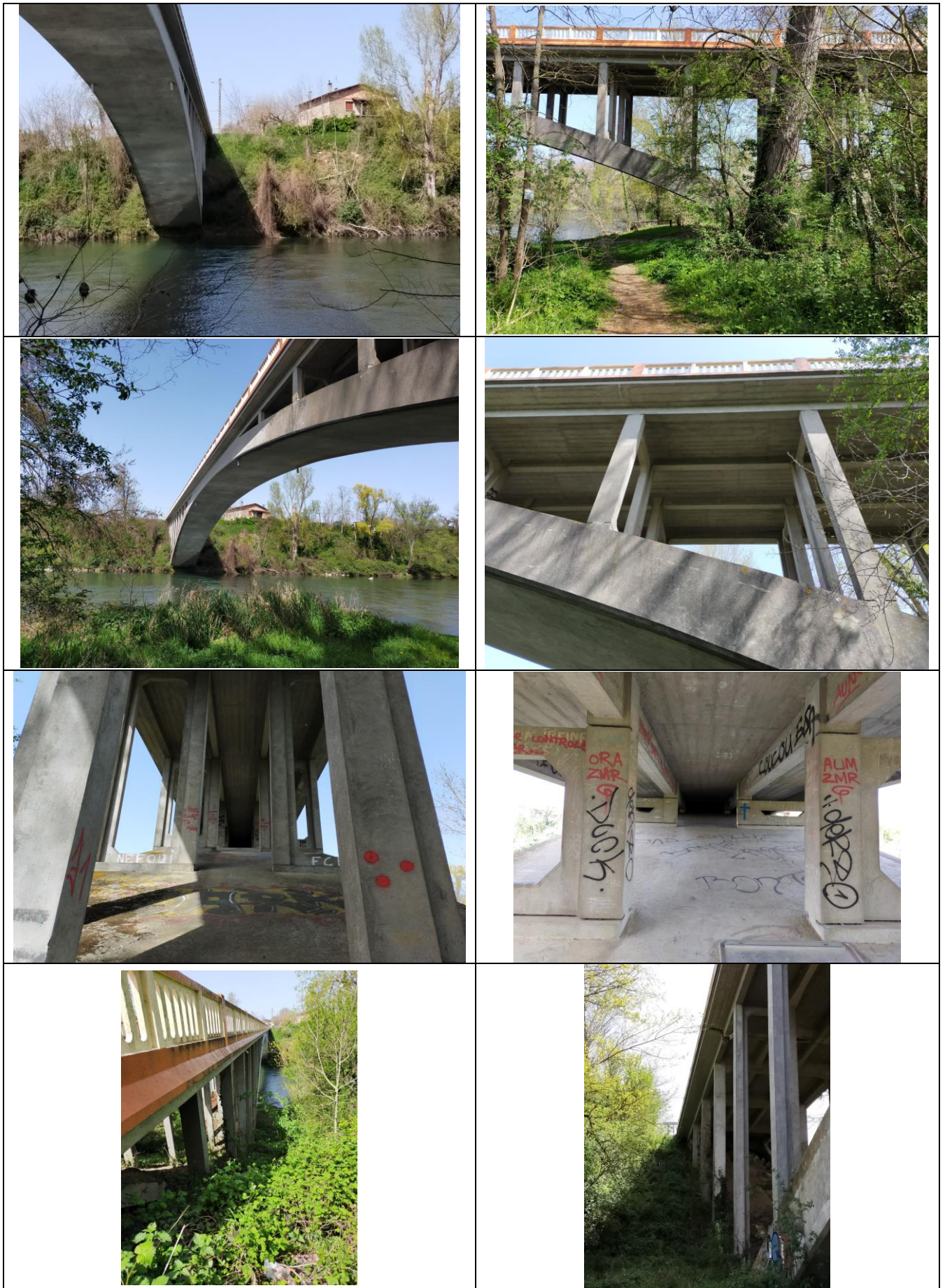
Figure 20 : Photographies du pont de Saint-Julien
