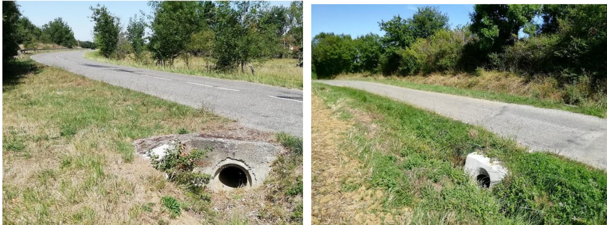
Figure 18 : Croisement des buses eaux pluviales – D62 (gauche) / La fontasse (droite)
