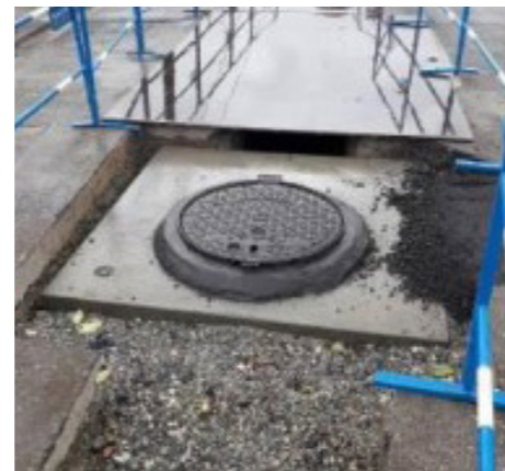
Regard combi III et grave bitume déjà réalisée
