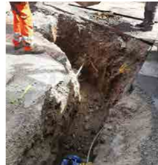
Terrassement au niveau de la vanne boulevard des Capelles
