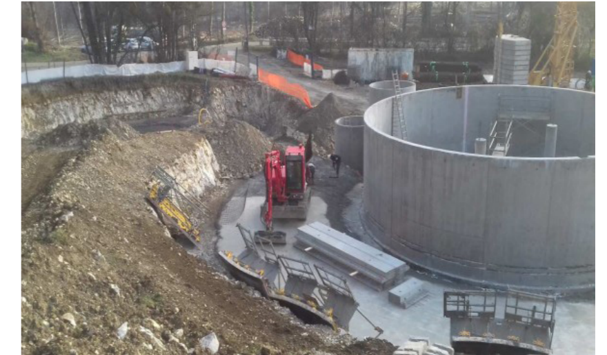
Travaux de construction de la station d'épuration de Salies du Salat
