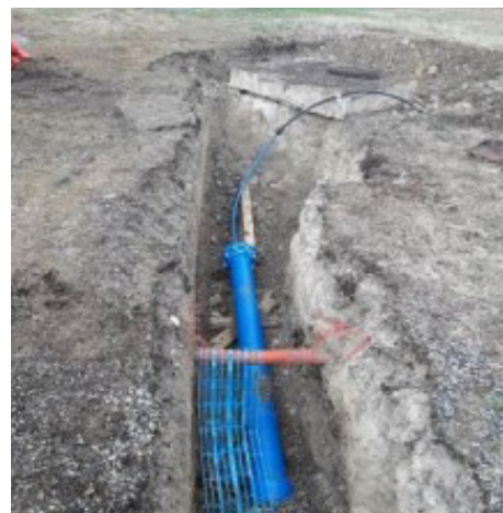
Préparation raccordement château d'eau
