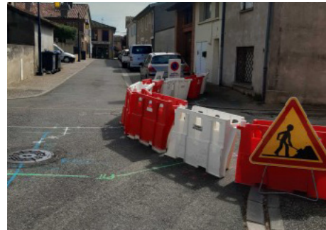
Signalisation route Barrée côté Rue Laurette
