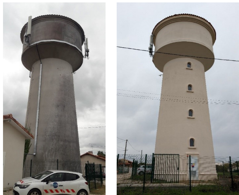
| Réservoir de Villaudric avant / après
